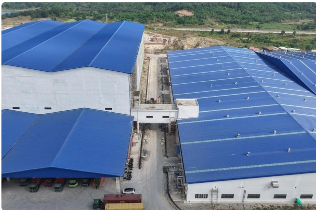
Area akses dan jembatan penghubung gudang
