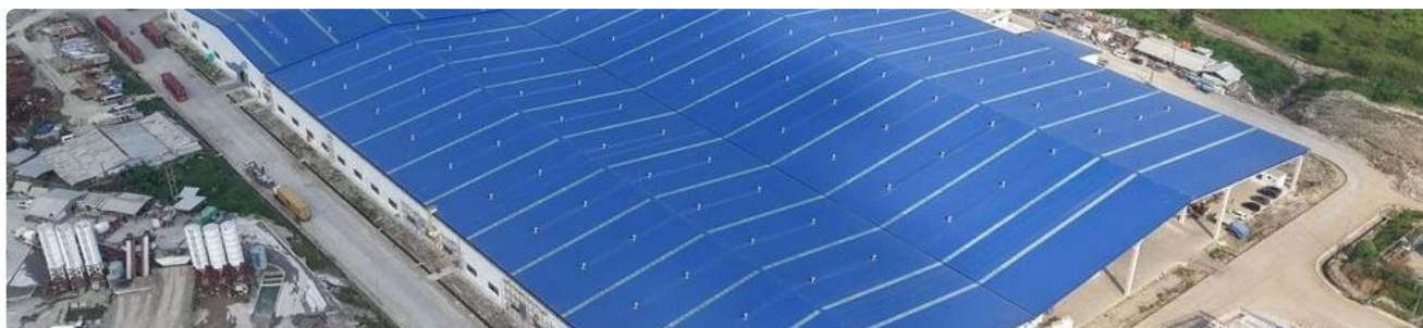
Instalasi turbin ventilator pada kawasan gudang produksi — PT Indah Kiat Pulp & Paper Tbk
