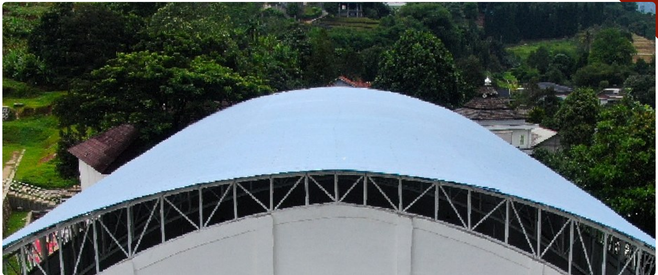
GOR Indoor Bogor Selatan — atap lengkung bentang lebar pada struktur rangka baja
