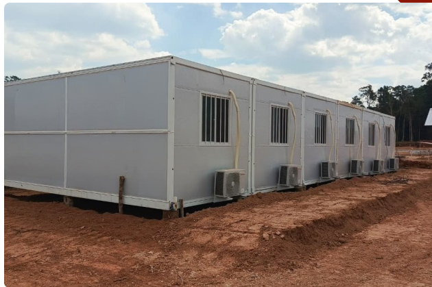
Unit modular terpasang lengkap dengan pendingin ruangan
