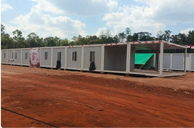
Deretan unit modular terpasang
