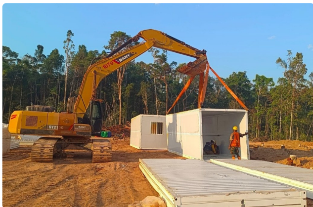
Proses perakitan unit modular di lapangan
