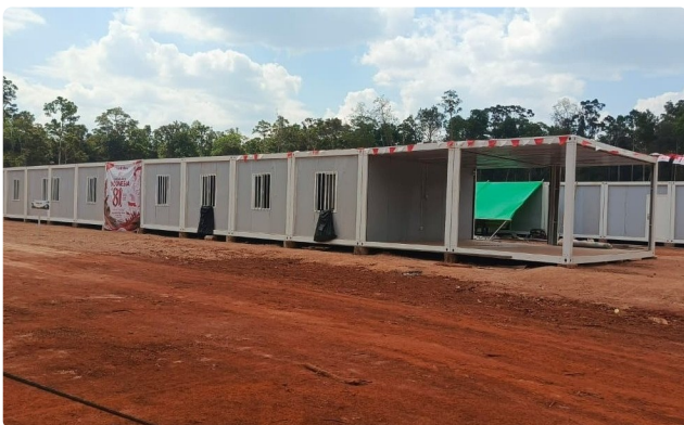
Deretan unit modular terpasang
