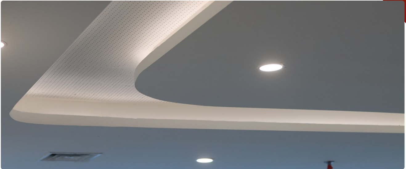
Plafon berundak dengan panel akustik berlubang
