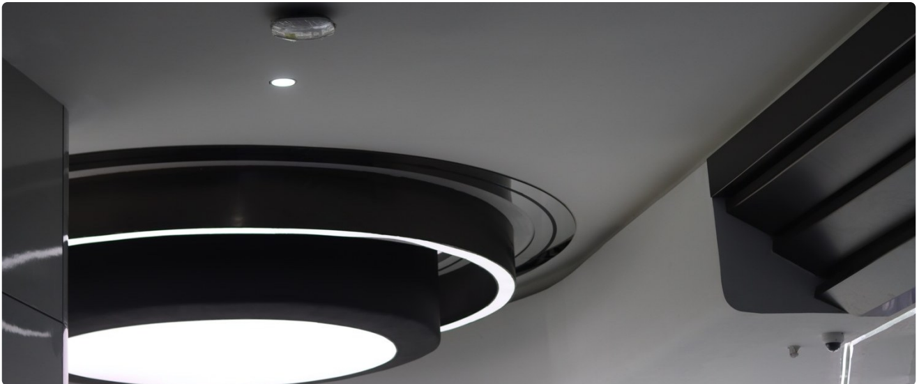
Plafon melingkar berlapis dengan cove lighting pada area lobi
