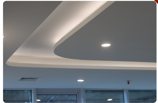
Plafon berundak dengan panel akustik berlubang
