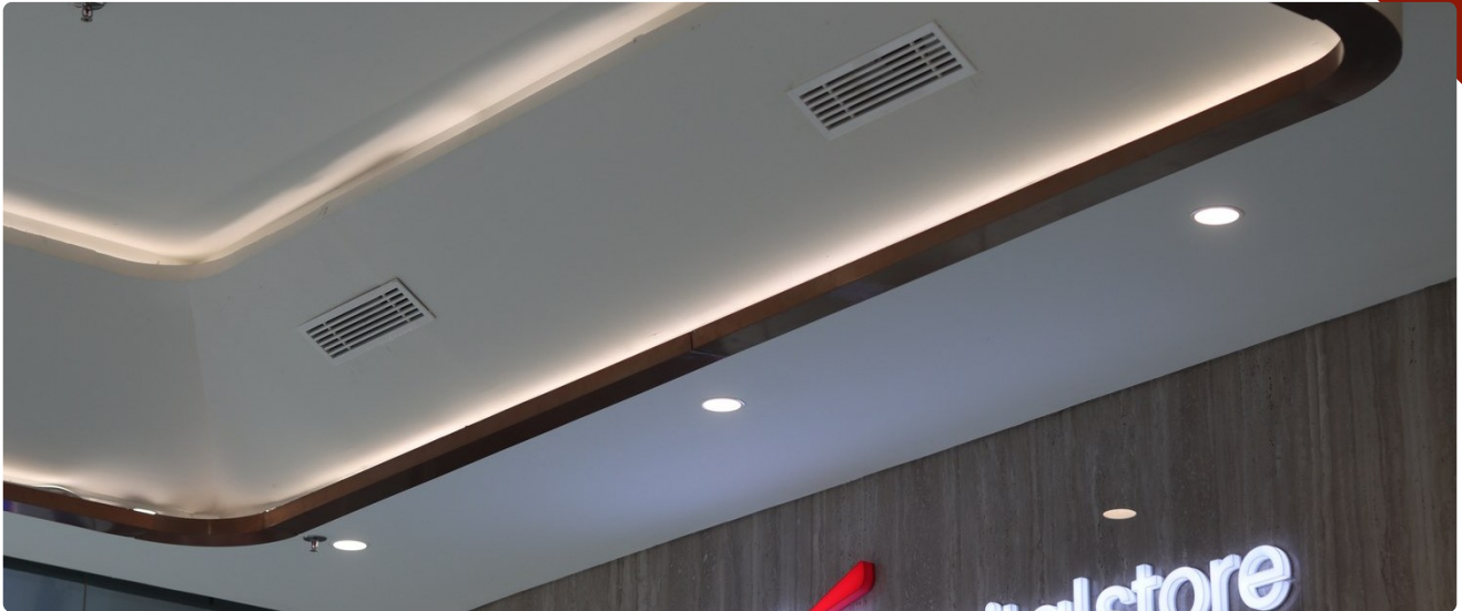
Plafon lengkung dengan cove lighting dan list kayu pada area gerai
