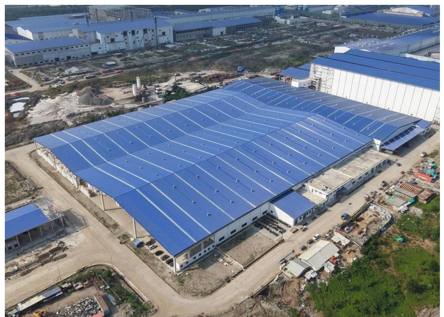
Cakupan instalasi pada area gudang tambahan
