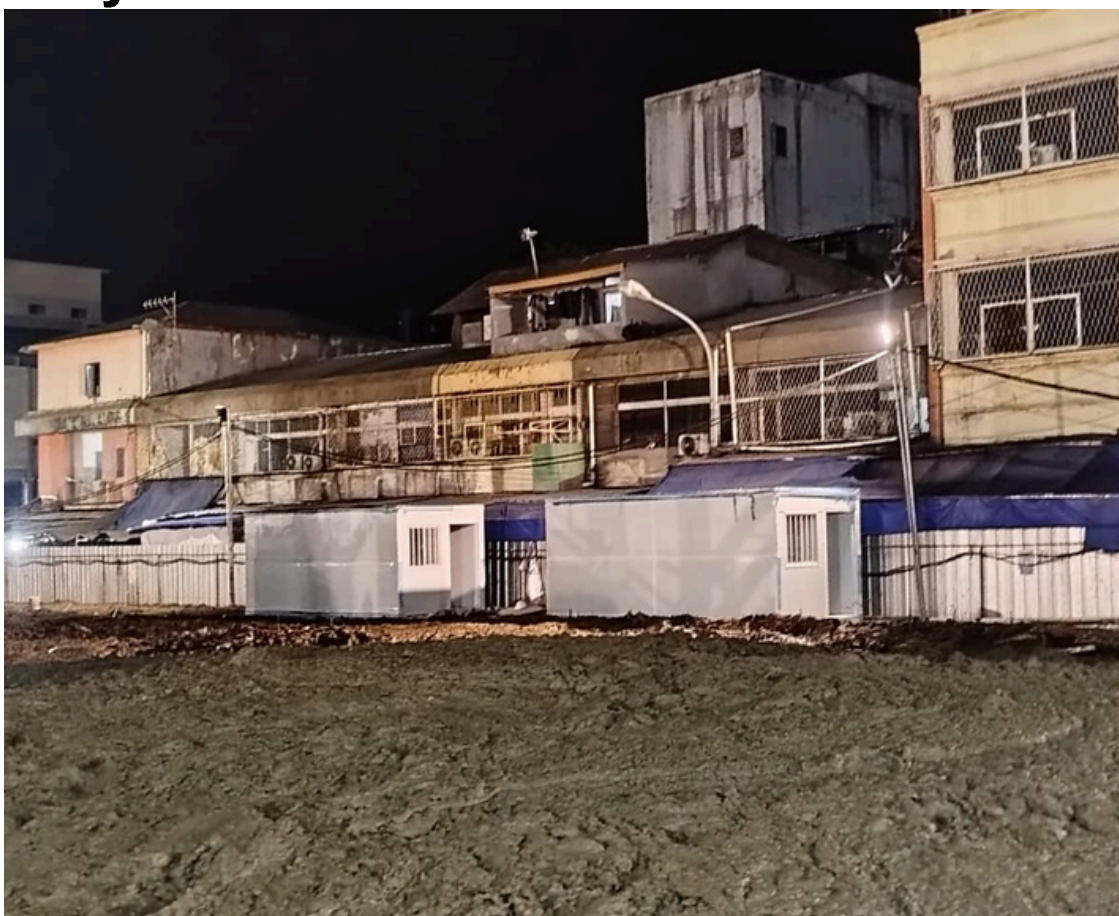
Proyek jaya konstruksi - Container Folding Pasar Muara Karang
