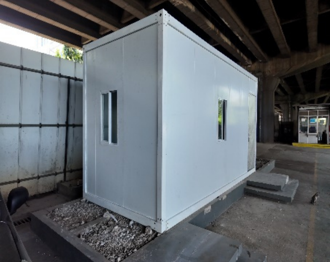
Proyek Rumah Pompa Ancol - Jaya Kontruksi
