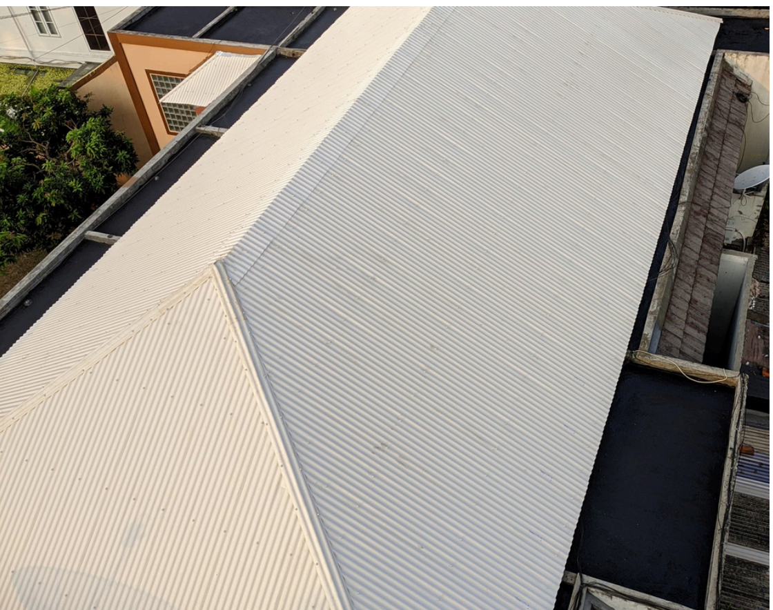
Proyek Rumahan - Pemasang Atap Alderon
