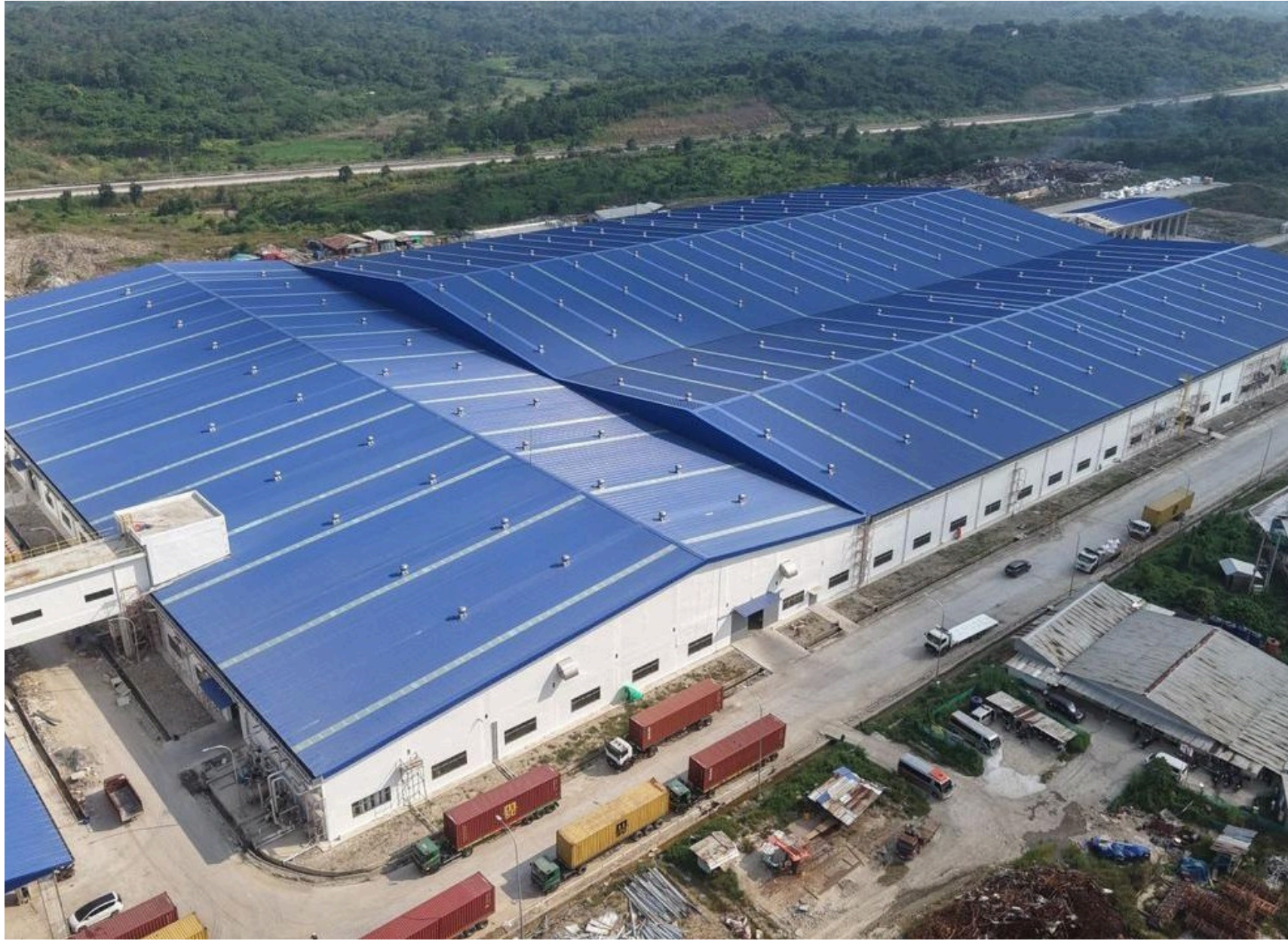
Instalasi Turbin Ventilator skala industri
