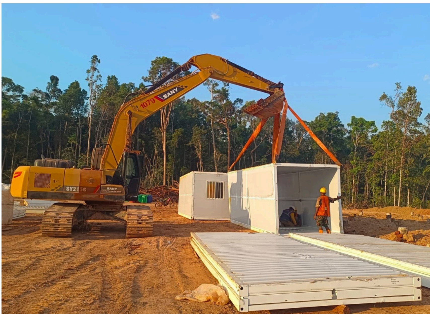
Proses perakitan unit modular di lapangan
