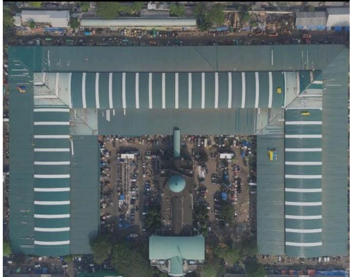
Proyek Reviltalisasi Pasar Induk Kramat Jati
