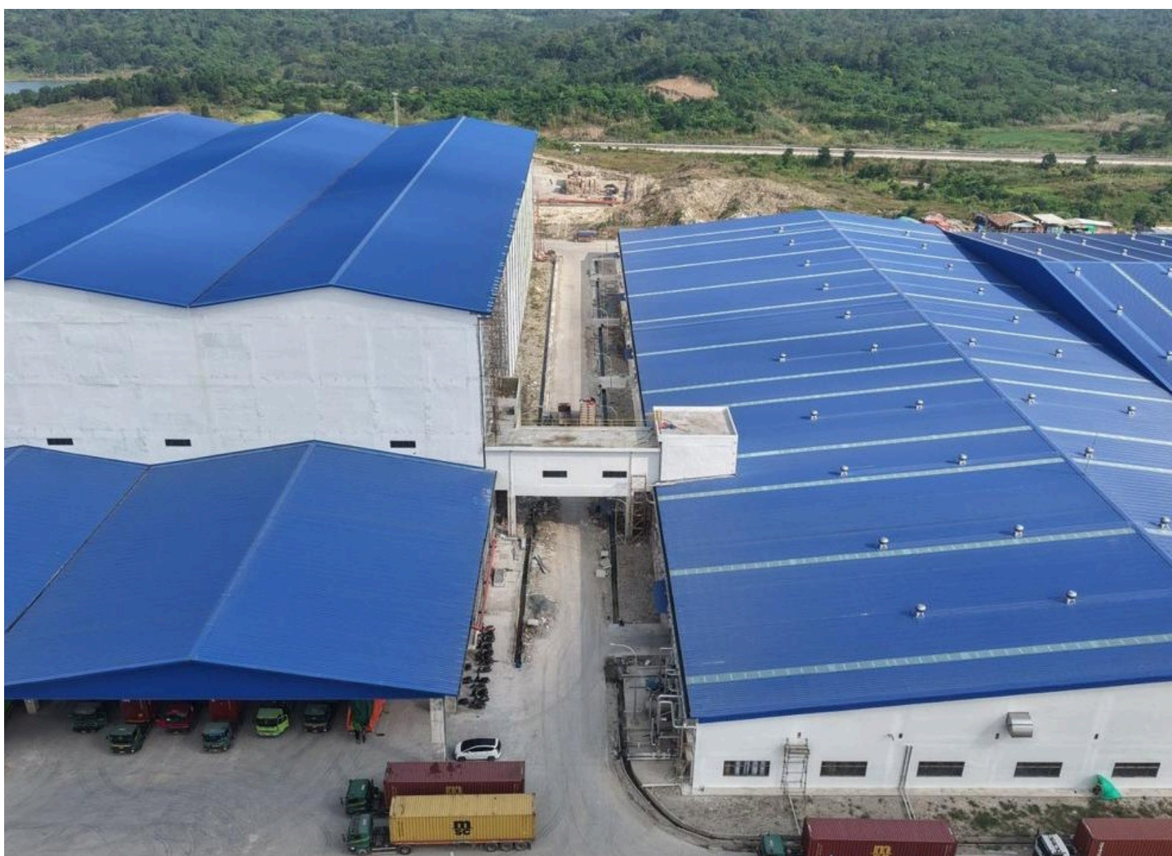
Area akses dan jembatan penghubung gudang
